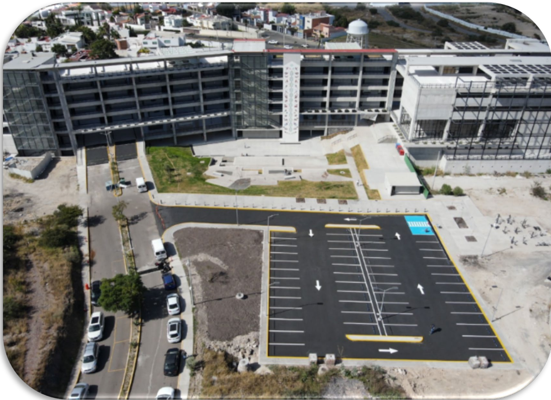
Foto 38. Estacionamiento de la ENES Juriquilla
