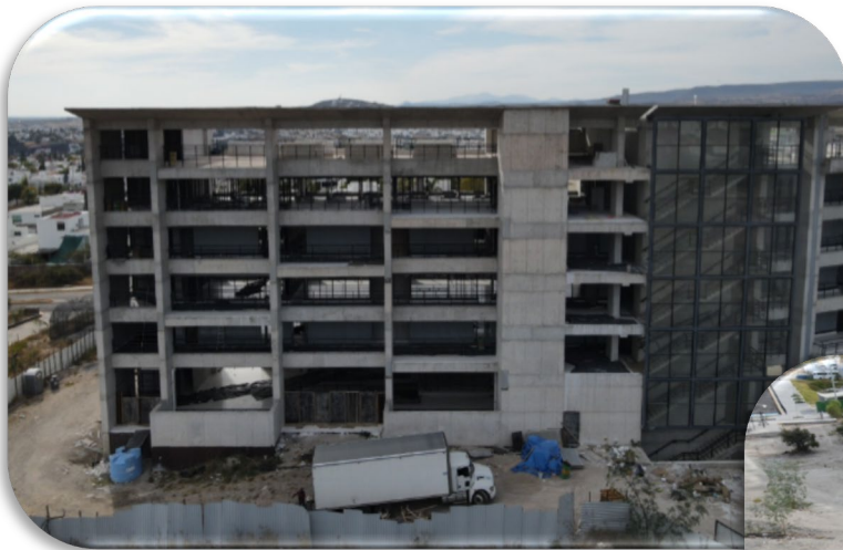
Foto 39. Estructura edificio III
