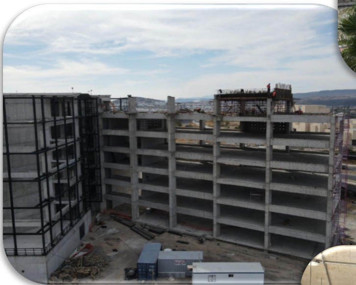
Foto 41. Estructura edificio VII
