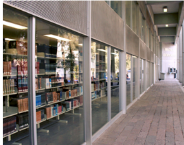
Imagen 4.6 Cambio de cancelería en ventanales y fachada principal de la biblioteca.
