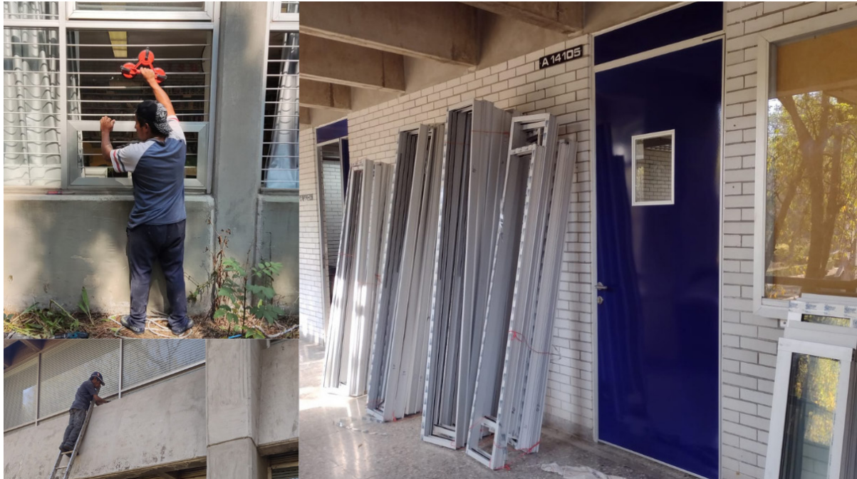
Instalación de ventilas para espacios cerrados.
