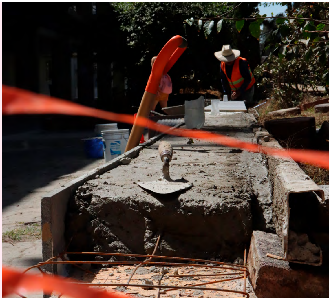
Realizando cambio y mantenimiento de equipo en el subsuelo se mejora el funcionamiento de tuberías
