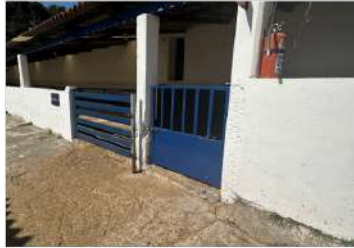
Se repararon y/o cambiaron las puertas de los corrales para los cerros del CCEIPO. Se dio mantenimiento a la herrería en el área de los corrales
