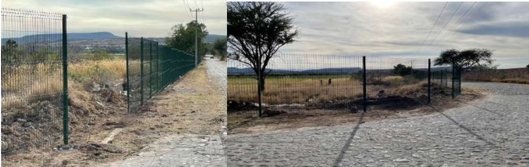
Colocación de malla en el lindero camino de Santillán
