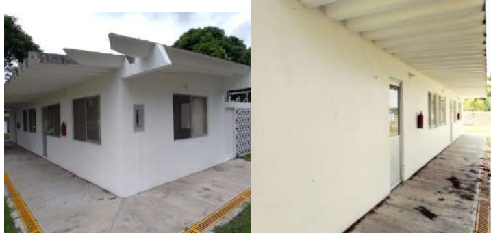
“La Soledad” área de oficinas
