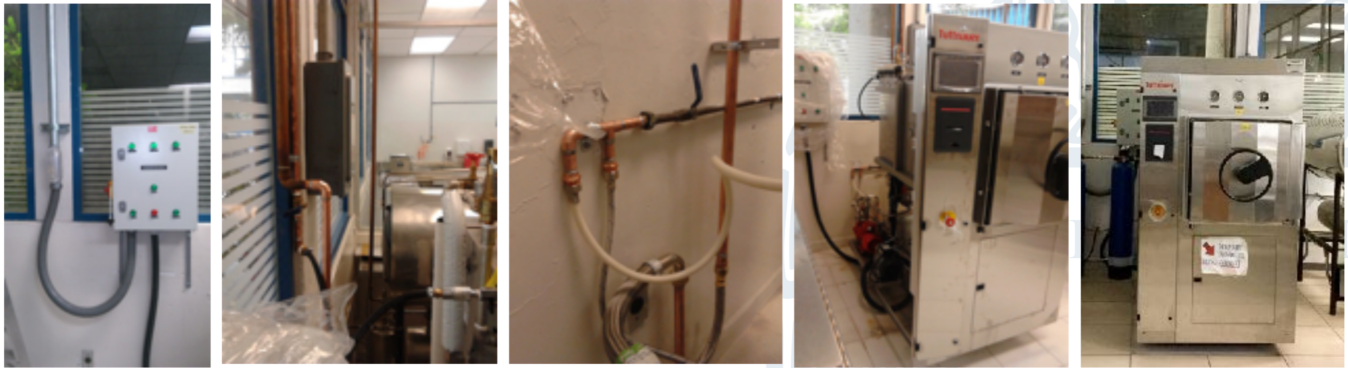
CONEXIÓN NUEVO AUTOCLAVE EN EDIFICIO CENTRAL
