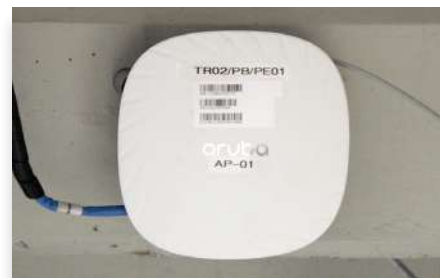
Instalación de antenas
