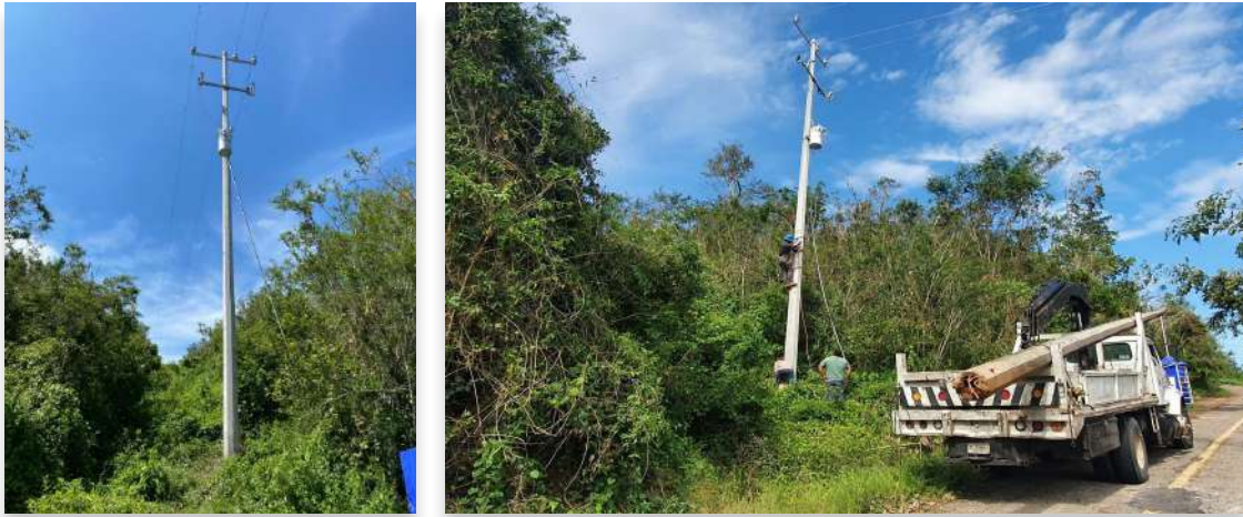
Replomeo de poste de líneas de media tensión dañado por Huracán Nora
