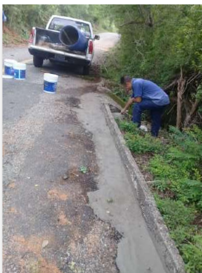
Mantenimiento a canaletas de desague por personal administrativo de la Estacion Chamela
