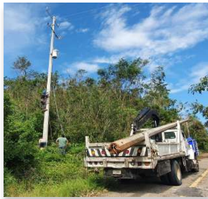
Replomeo de poste de líneas de media tensión dañado por Huracán Nora
