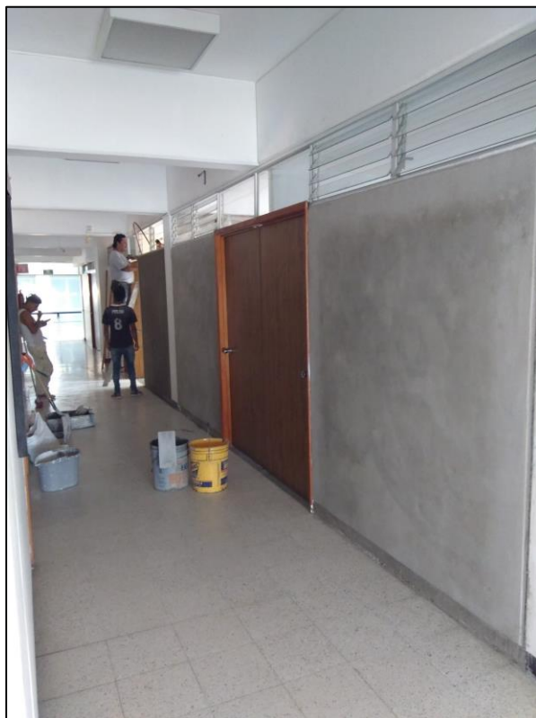
Figura 29. Reparación de muros por daños por el sismo del 19 de septiembre de 2017
