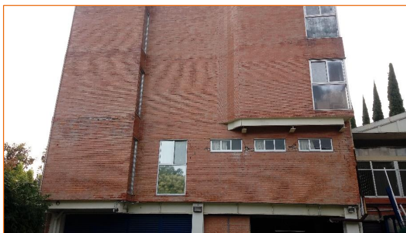
Figura 34. Muro del edificio “D” dañado por el sismo.
