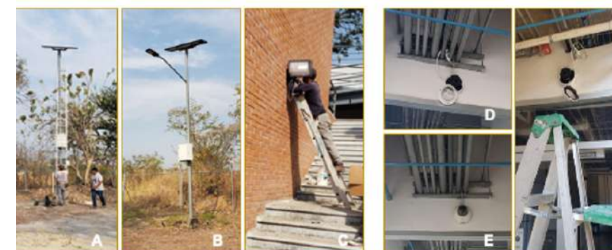
Imágenes A, B y C: instalación y mantenimiento de las luminarias en áreas faltantes, D, E y F: mantenimiento de cámaras Hikvision para reforzar la seguridad institucional.
