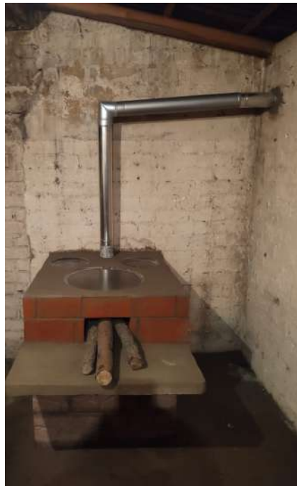
Fotografía 1: Estufa de leña eficiente co-seleccionada por una familia integrante del proyecto en Atlautla, Edo. de México. (IER-UNAM, Universidad de Birmingham, IIES-UNAM, UCL financiado por CONACyT-Newton Fund).
