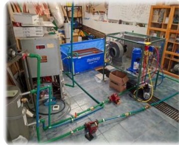
Pruebas de la bomba de calor mexicana en Laboratorio
