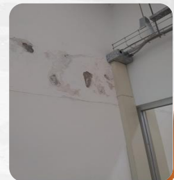
Reparación de apelando dañado por humedad - Edificio 3
