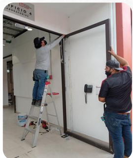
Cambio de bisagras de puerta de laboratorio - Edificio 4
