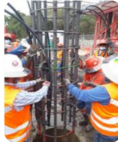
Construcción de una pila de energía de prueba
