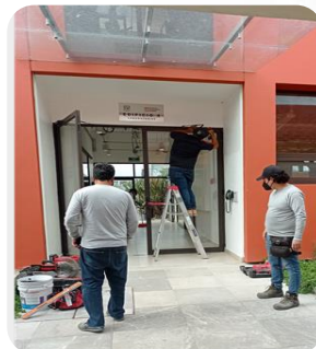
Cambio de bisagras de puerta de laboratorio - Edificio 4
