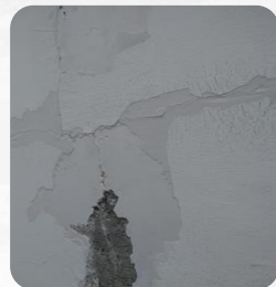
Reparación de apelando dañado por humedad - Edificio 3
