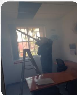
Reparación de apelando dañado por humedad - Edificio 3
