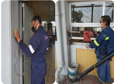
Extracción de núcleos de concreto
