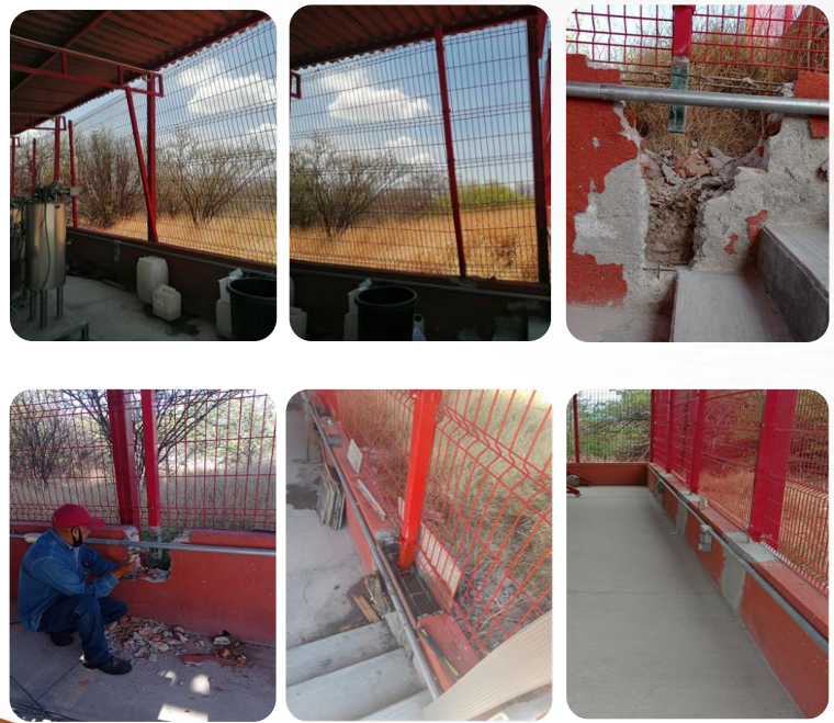
Reparación de malla de pilotos externos
