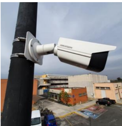
Ilustración 46. Instalación de cámaras IP
