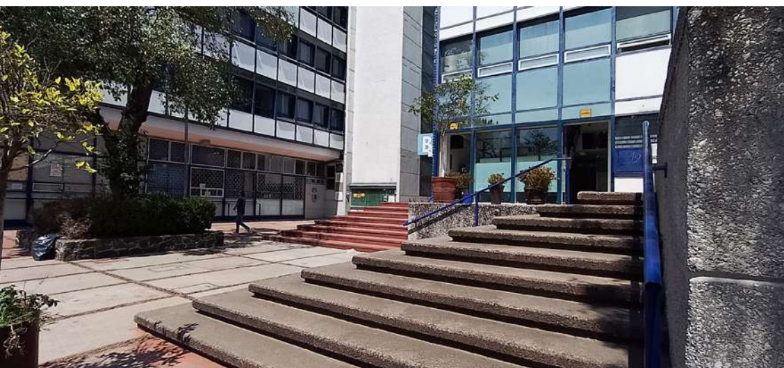
Adecuación de espacios en el edificio B
