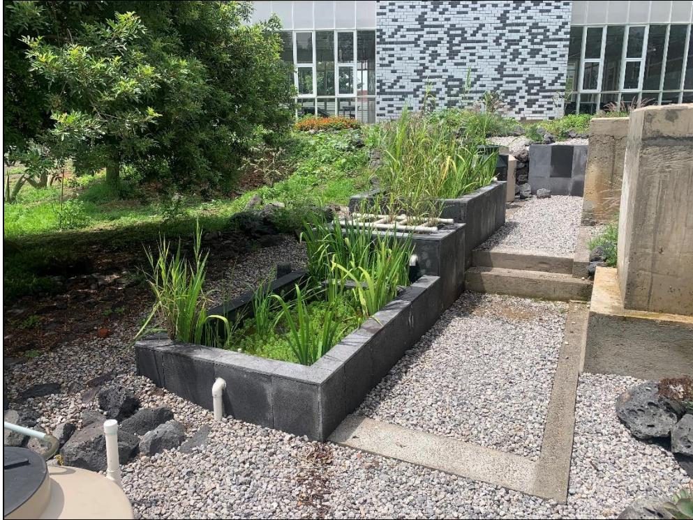
Figura 18. Humedal instalado en la ENCIT
