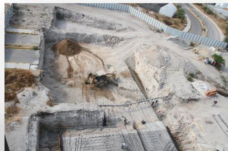
Foto 61. Excavación para cimientos del Edif. IV
