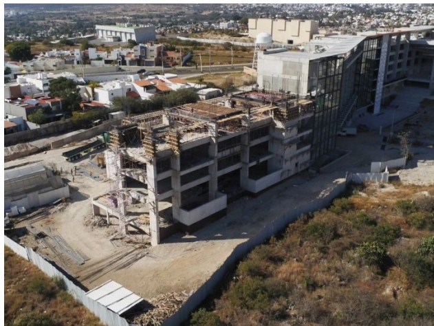
Foto 9 Construcción del edificio III de la ENES Juriquilla
