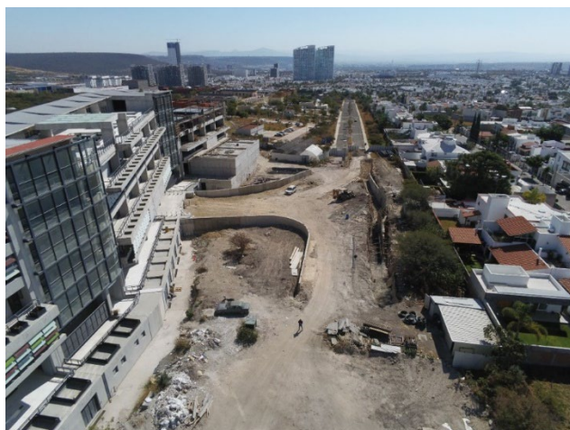
Foto 10 Construcción de Foro y espejo de agua
