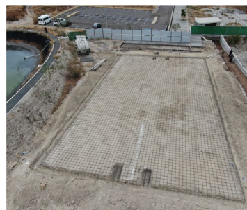
Septiembre: Comenzó la construcción de las canchas multiusos
