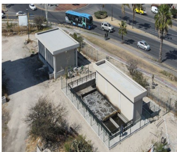
Septiembre: Se llevó a cabo la puesta en marcha de la planta de tratamiento de aguas residuales
