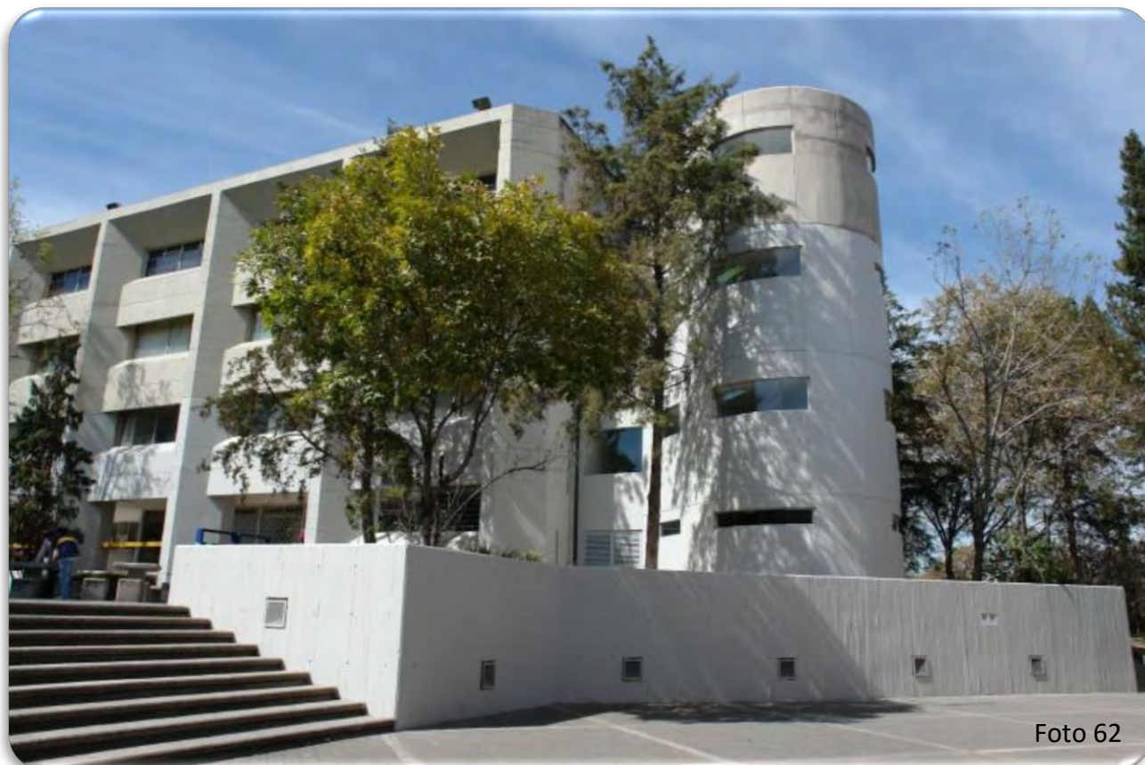
♦ Escaleras del edificio "A".
