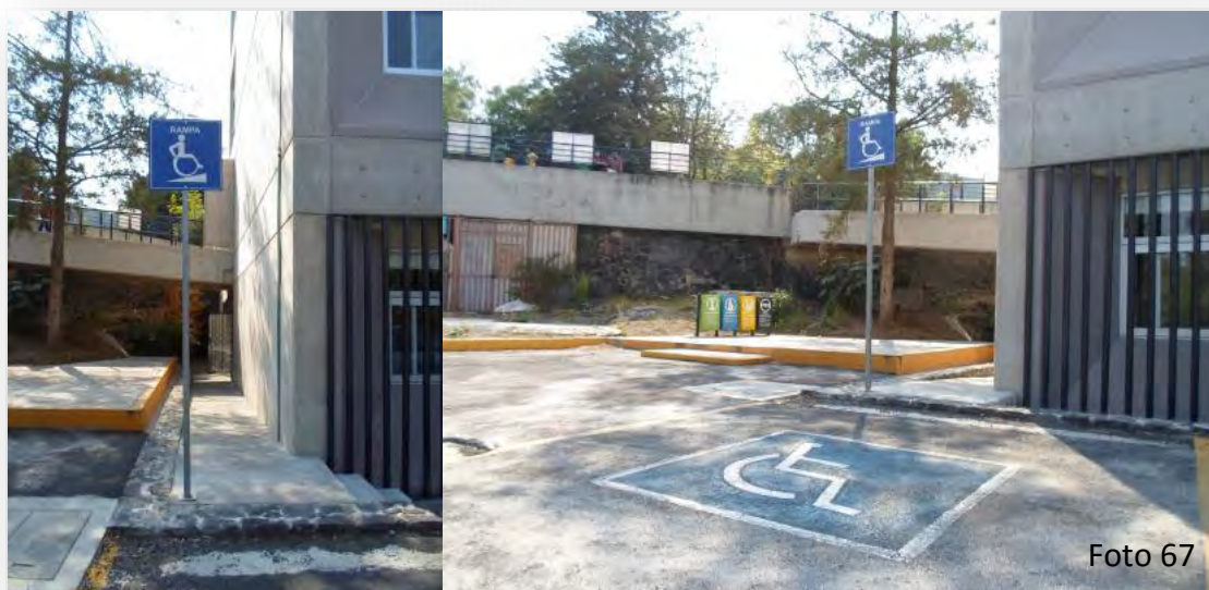
♦ Construcción de rampas y lugares de estacionamiento para personas con discapacidad.
