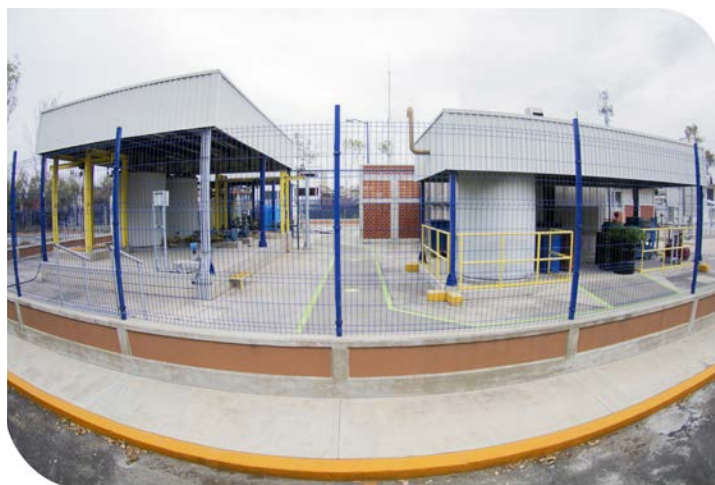
Planta de Tratamiento de Aguas Residuales.
