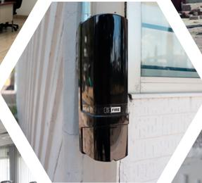
Instalación de sensores de movimientos (Edificio de Ingenierías y planta baja del A4)
