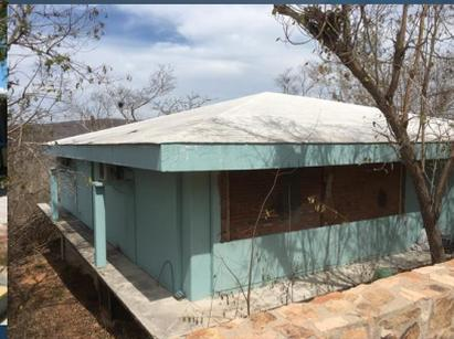
Reemplazo de ventanas con muro tapón
