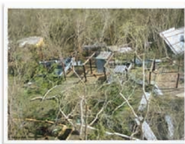
3. Vista estacionamientos y patio central
