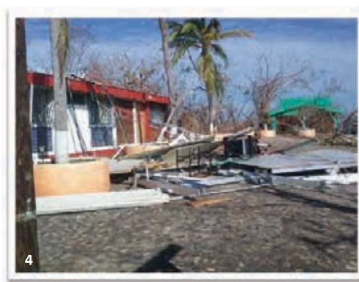
Caseta de la Red Universitaria de observatorios Atmosféricos (RUOA) antes (1), y después de "Patricia" (2-4)
