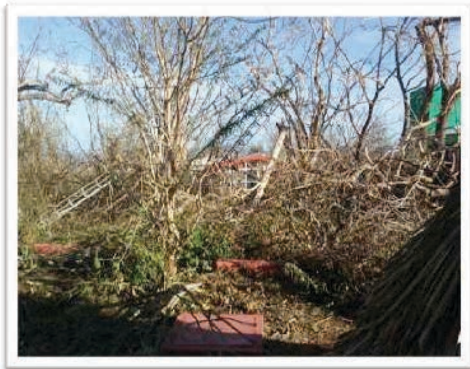
3. Tapa cemento sobre aljibe deslizada por viento
