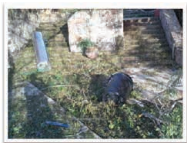
1. Calentadores solares derribados
