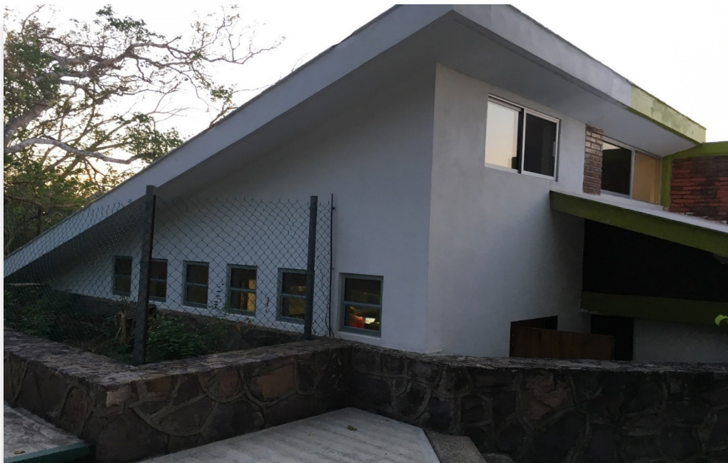
Ampliación cocina-comedor de la Estación de Biología Chamela
