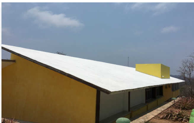
Recubrimiento de la loza del techo del edificio de la biblioteca.
