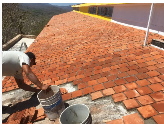
Recubrimiento de la loza del techo del edificio de la biblioteca.
