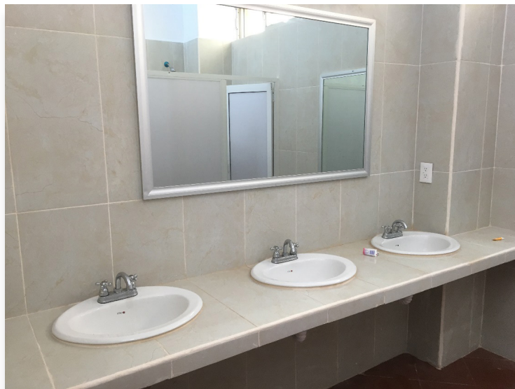
Remodelación de los baños de visitantes e investigadores
