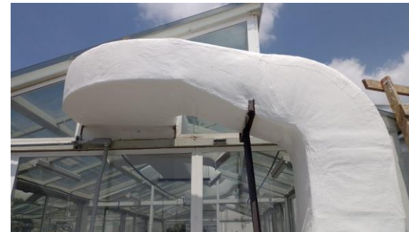
Impermeabilización de ductos de aire acondicionado en el invernadero y azoteas
