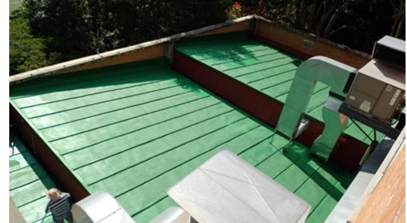
Impermeabilización de azotea auditorio.
