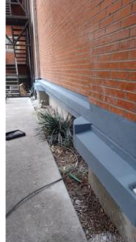
Drenaje en edificio norte
