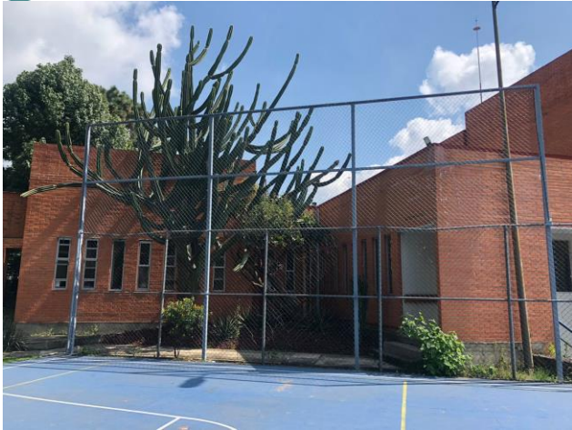
Colocación de postes cuadrados en cancha de voleibol para fijar la malla.
