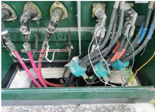
Reubicación de cable de control y servicio de limpieza
