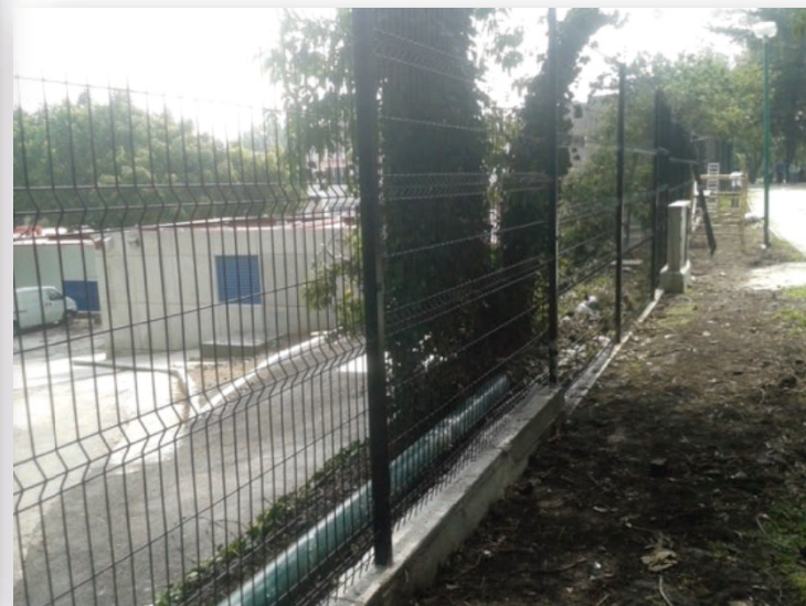
Sustitución de la reja perimetral
