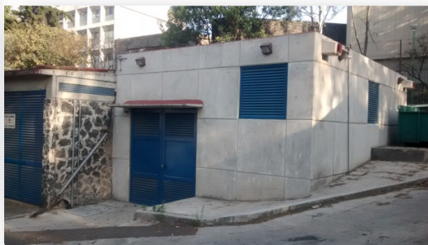
Nueva subestación eléctrica
