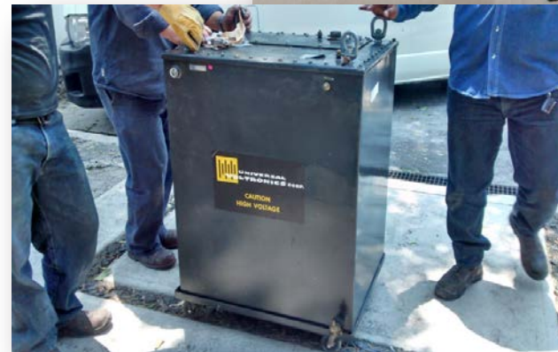
Retiro del transformador de aceite con ascareles
