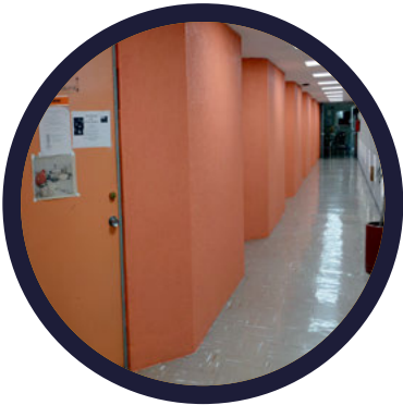
Mantenimiento de instalaciones
