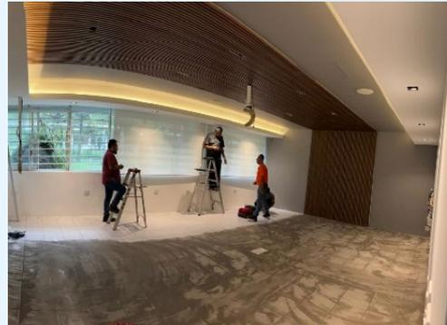
Reacondicionamiento de site de telecomunicaciones en edificio principal Ma. Teresa Gutiérrez en 1er y segundo piso, para la nueva infraestructura de telefonía del Instituto, con un costo de inversión de \$73,000.00, consistente en colocación de muros aparentes de Tablaroca, terminado en pintura, instalación eléctrica y de iluminación.
