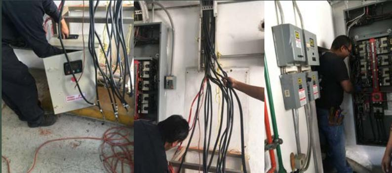
Instalación de UPS y tablero eléctrico en el edificio Anexo I
