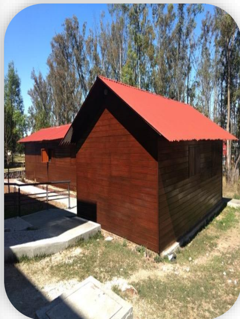
Mantenimiento a cabañas: barnizado y sustitución de madera, se conectaron al UPS de la Unidad
