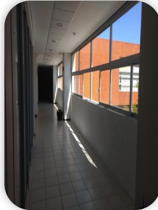
Cancelería en pasillo
