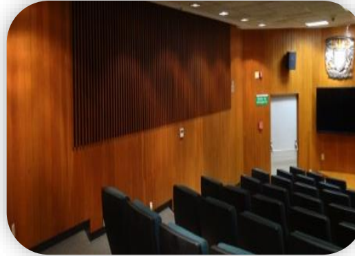
Se sustituyeron ventanas por sistema acústico
