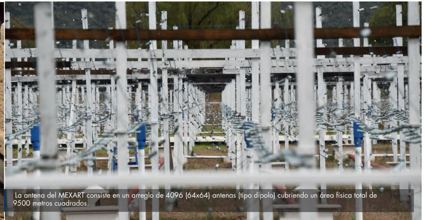
La antena del MEXART consiste en un arreglo de 4096 (64x64) antenas (tipo dipolo) cubriendo un área física total de 9500 metros cuadrados.
