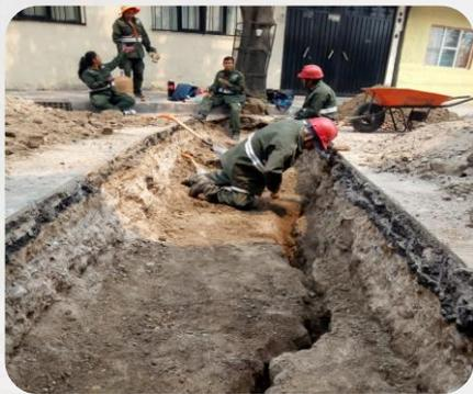
Construcción de una caja disipadora de deformaciones para rehabilitación de vialidades
