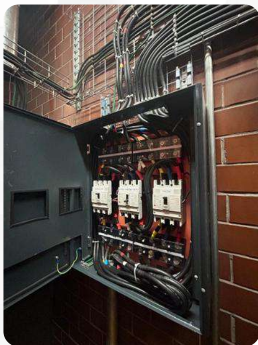
Colocación de sistema “by pass” en el centro de datos del Edificio 12
