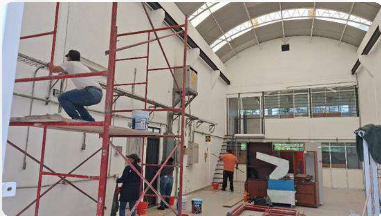
Remodelación de Interior de Edificio
