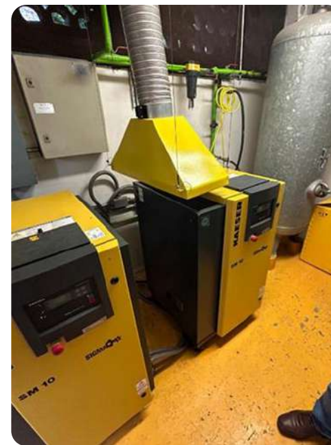
Cambio de Equipo Controlador de Aire Comprimido del Laboratorio de Mecánica de Suelos
