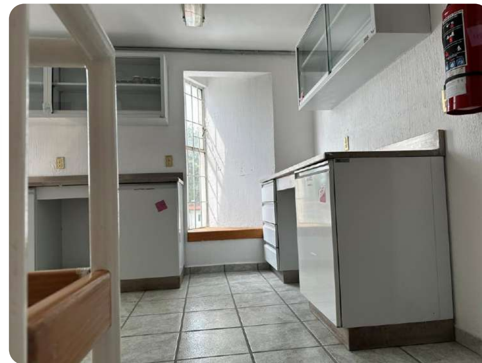
Remodelación de Interior de Edificio (Laboratorios)
