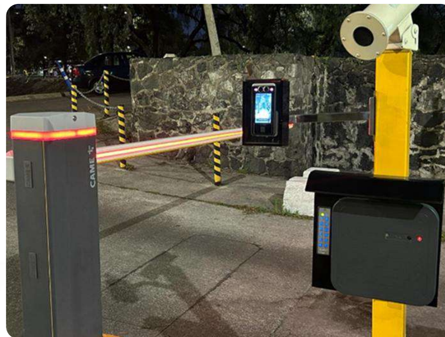
Instalación de Sistema Biométrico
