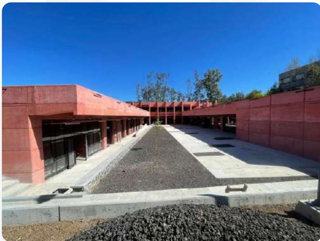
Construcción de UA Morelia
