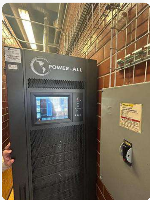
Colocación de sistema “by pass” en el centro de datos del Edificio 12
