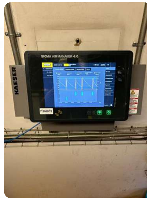
Cambio de Equipo Controlador de Aire Comprimido del Laboratorio de Mecánica de Suelos
