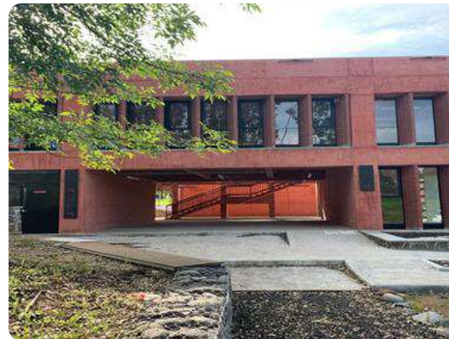
Construcción Concluida de UA Morelia
