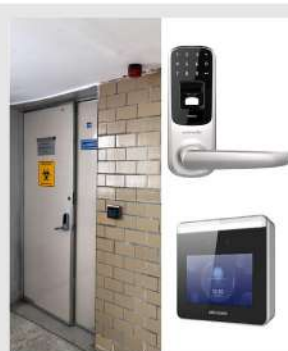
Accesos con control biométrico (huella digital y reconocimiento facial)
