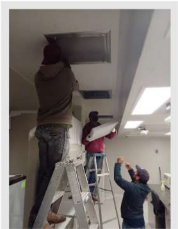
Instalación de gabinetes y filtros HEPA del sistema de extracción
