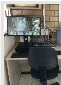
Instalación de cámaras de videovigilancia
