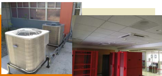
Figura 14. Sistema de enfriamiento Tipo CASSETE CARRIER, capacidad de 48, 000 BTU/Hr.
