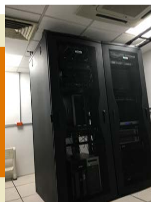
Figura 31. Remodelación del cuarto de servidores, cambio de plafón y luminarias.
