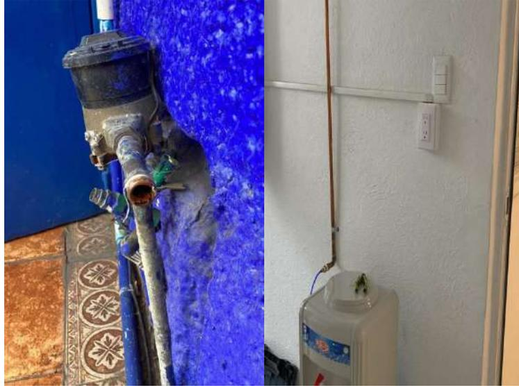
Instalación de tubería de cobre para los dispensadores de agua, sede Tlalpan del PUIC
