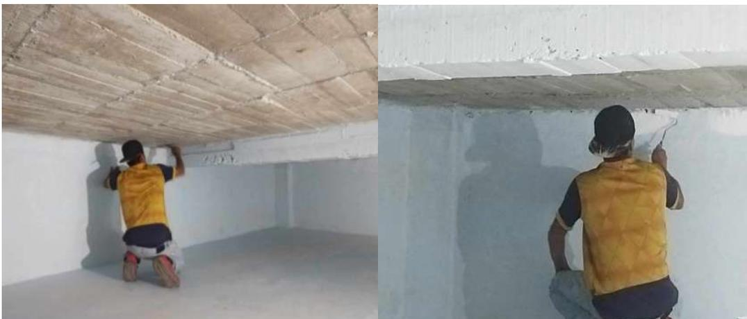
Impermeabilización de cisterna, sede Tlalpan del PUIC
